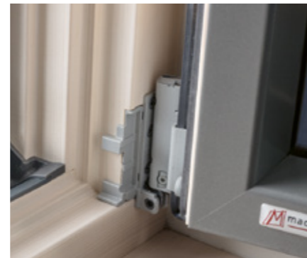
Außenliegend eingefräster, dreidimensional verstellbarer Beschlag
