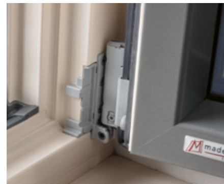
Außenliegend eingefräster, dreidimensional verstellbarer Beschlag
